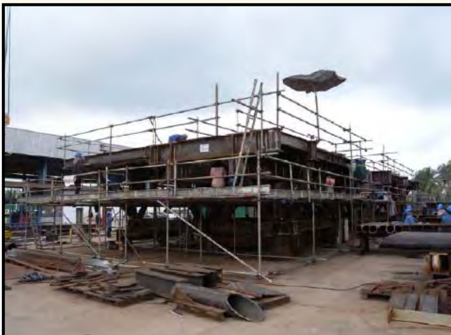
Fabricação e Montagem da Parte Inferior – Riser Porch
