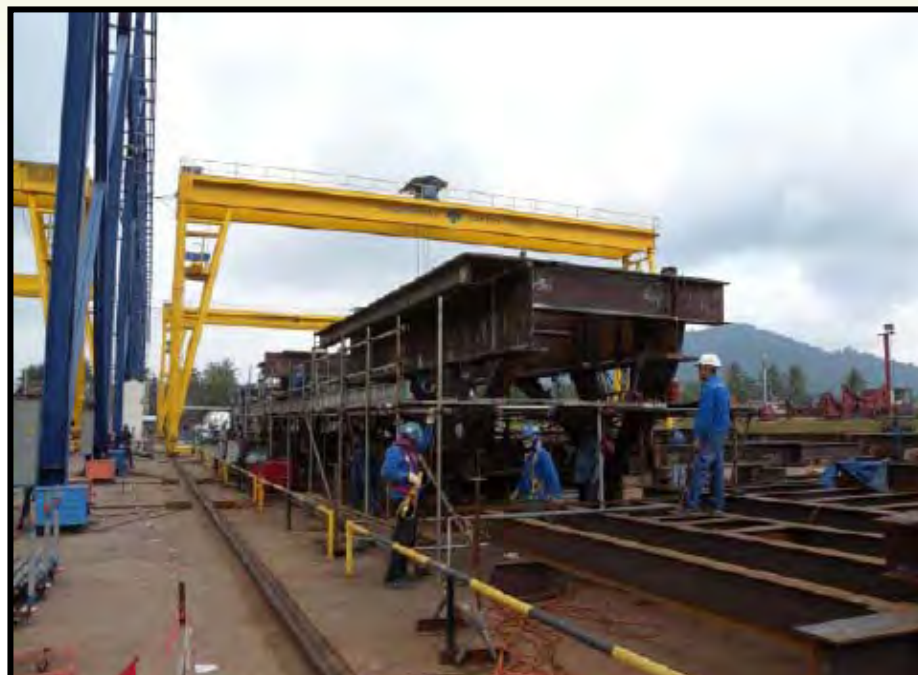
Fabricação e Montagem da Parte Superior – Riser Porch
